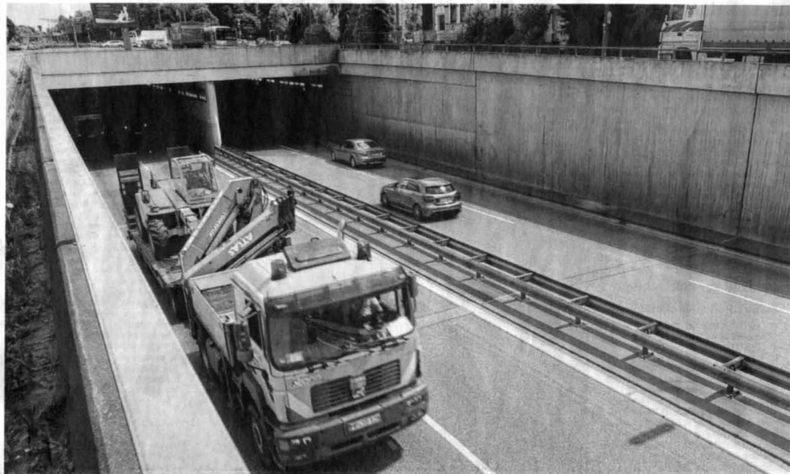
Das Trogbauwerk zwischen Neuenlander Straße und Zubringer Arsten wird für die Dauer des Baus der A 281 zum Nadelöhr. Mehr Verkehr im Stadtteil wird die Folge sein.
