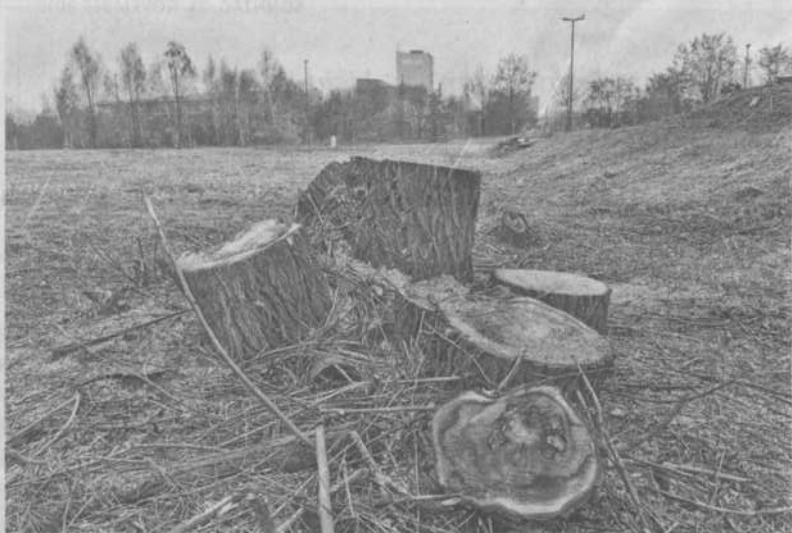
An der Carl-Benz-Straße haben mit ersten Rodungen die vorbereitenden Arbeiten für den Bau der Weserquerung im Zuge der A281 begonnen. Im Hintergrund das Stahlwerk. Foto: Schlie
