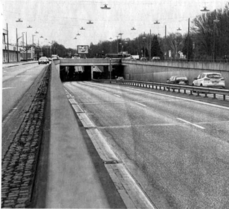
Die Auswirkungen durch den Komplettabriss des Tunnels vom Arster Zubringer am Knotenpunkt Kattenturm Heerstraße/ Neuenlander Straße wurden in der Beiratssitzung zum Nebenschauplatz.
