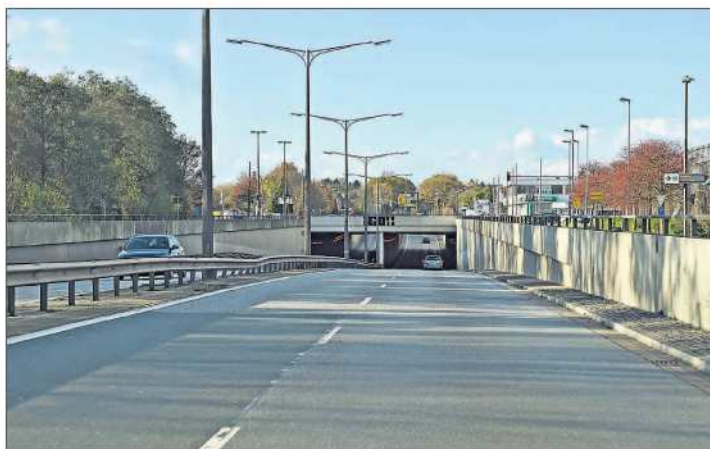
Der Tunnel, der die Bremer Neustadt mit dem Autobahnzubringer zur A 1 verbindet, soll zur Großbaustelle werden. Anwohner befürchten erhebliche Verkehrsprobleme. Foto: Schlie
